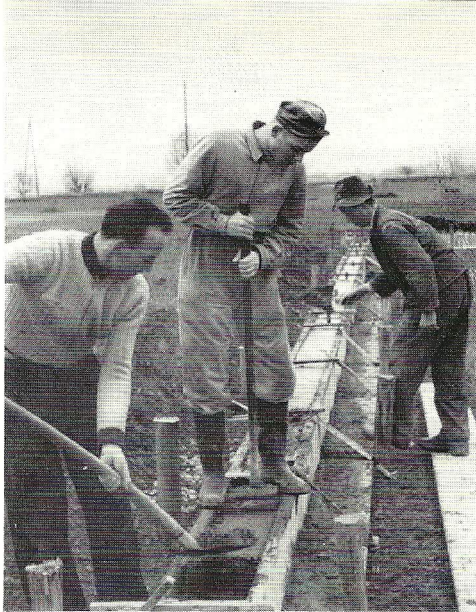
Bau der Fundamente für das neue Fliegerheim
